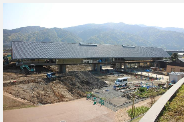
図5. 建設中の福井県年縞博物館
