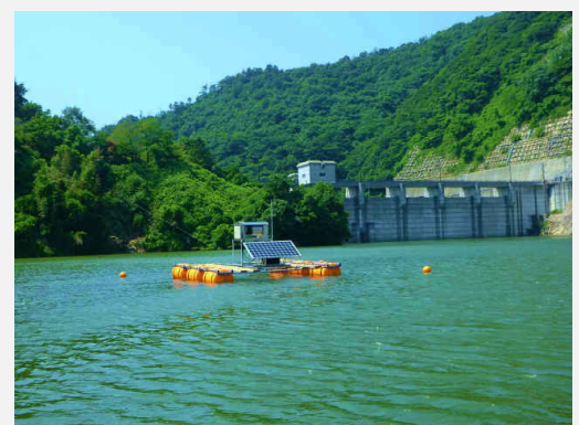
図2 貯水池用水質計自動昇降装置
