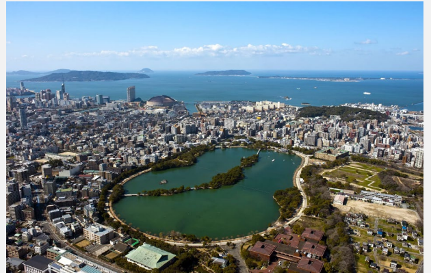
大濠公園の全景（提供：福岡県）
