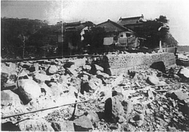
写真-1 永尾地区の被災状況
