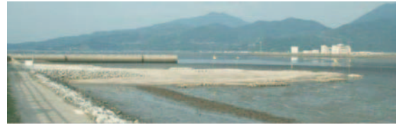
熊本港「東なぎさ線」:人工護岸前面に「なぎさ線」を造成して地形の連続性と生態系の連続性を創出
