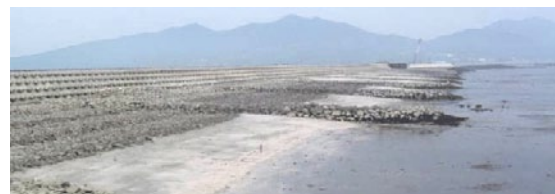
消失した生物生息場が回復するとともに景観・親水機能も向上(熊本県玉名横島海岸)
