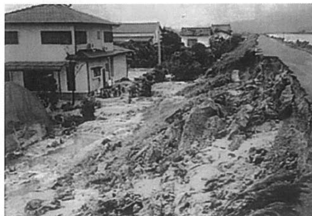
写真-6 砂川の被災状況
