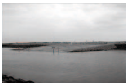
写真-2 熊本港「北なぎさ
