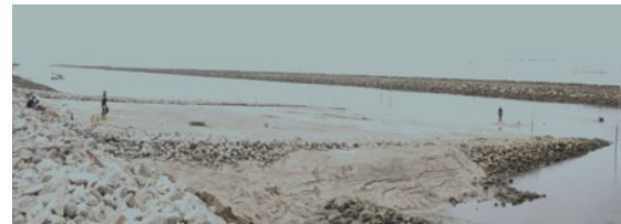
熊本港「北なぎさ線」:多数のアサリ貝やタイラギ等の着床・生残を確認
