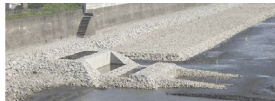
エコテラス護岸:上段に植栽テラス、中段に潮溜まり、下段にはテラス干潟を配置
